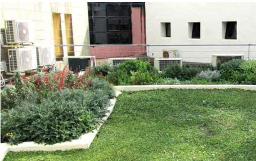
La quantità di acqua ritenuta in questi tetti dipende anche dal tipo di materiale di drenante usato. Alcuni moduli di drenaggio possono ritenere una quantità sostanziale di acqua, evitando così allagamenti. Il volume dell'acqua trattenuta dal substrato dipende dalla frequenza e intensità di queste precipitazioni - più ravvicinate sono le piogge, minore è l'acqua trattenuta (Berndtsson, 2010) (Stovin, 2012).
